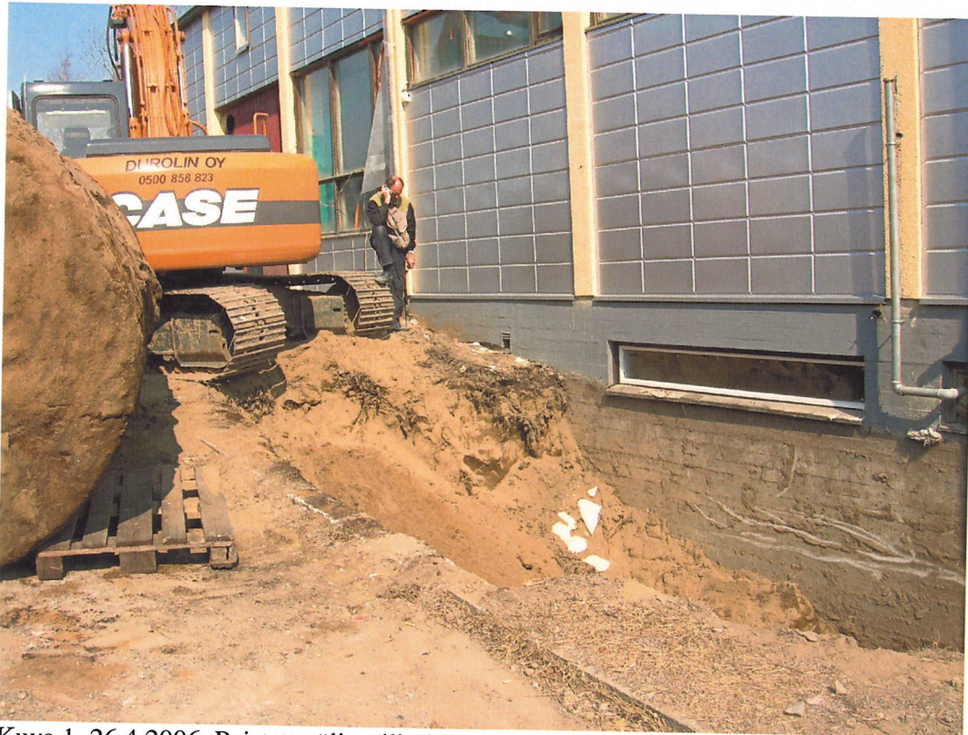
Kuva 1. 26.4.2006. Poistettu öljysäiliö kuvassa vasemmalla.
